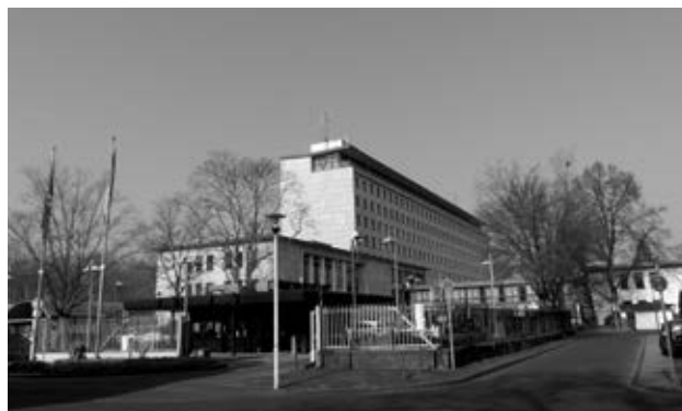
Der Gebäudekomplex war 1954 bis 1999 Sitz des Auswärtigen Amtes und ist seit 1999 zweiter Dienstsitz von Bundesjustizministerium und Auswärtigem Amt
